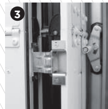
Paumelles réglables en acier galvanisé
